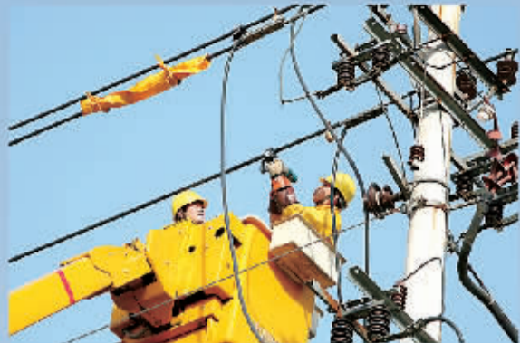
10千伏配网线路带电作业
