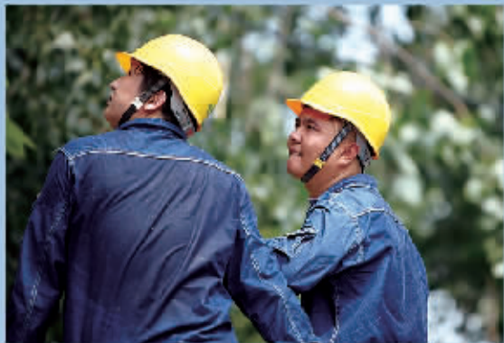
烈日下的电力抢修工人
