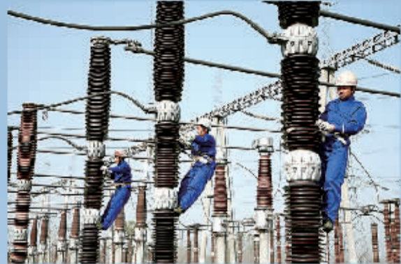
变电站设备维修
