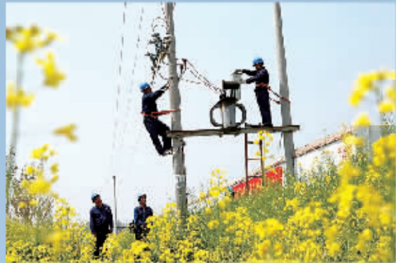
农村电网建设改造工程
