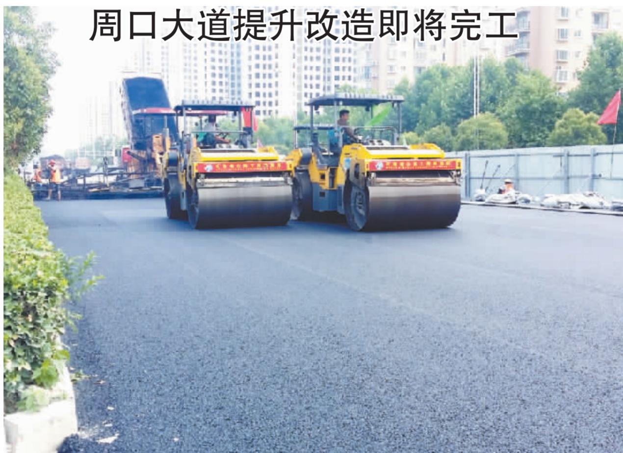
本报讯(记者 李文/图)“该项目于5月27日开工建设,目前主干道西半幅已经完工通车,东半幅水泥稳定碎石已经完成,正在铺设第一层沥青油面。”7月11日,在周口大道施工现场,该项目相关负责人史松告诉记者。
