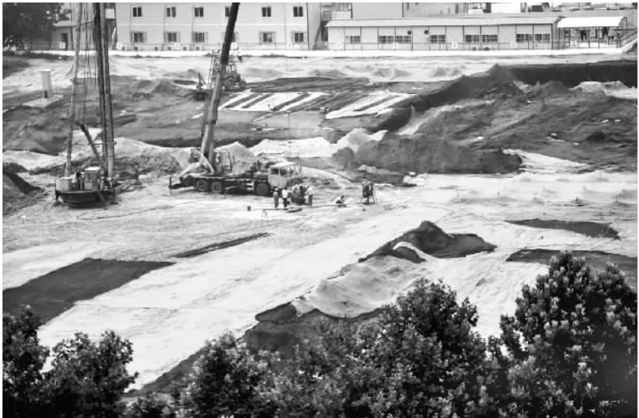
近日,市体育中心游泳馆工地物料穿上“防护衣”,防止扬尘。建筑工地粉尘、扬尘污染不仅影响市容而且污染大气,给市民生活和身体健康带来不利影响。为此,市委、市政府硬起手腕治理中心城区粉尘、扬尘污染。通过努力,逐步实现了施工现场围挡率、进出道路硬化率、工地物料蓬盖率、场地洒水清扫保洁率、密闭运输率、出入车辆清洗率“6 个 100%”,确保我市大气环境不断改善,空气质量不断提升。
