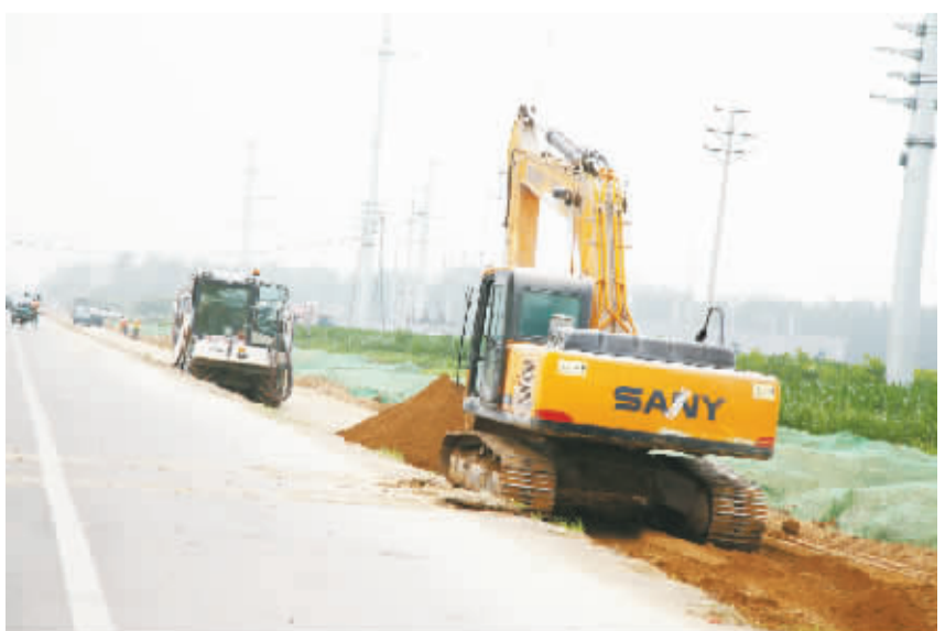
7月13日,项城市南环路东段施工工人正在进行道路拓宽作业。据了解,南环路西段道路拓宽后,已初步完成路面铺装任务。张永久 李光辉 摄
