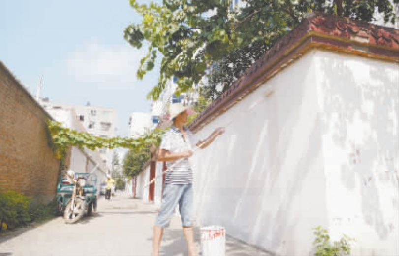
莲花办事处积极参与文明城市创建工作,日出出动清洗车 6 辆,重点整治主干街巷的墙体广告、占道经营等。图为该办事处人员在粉刷墙面。蒋树保 摄
