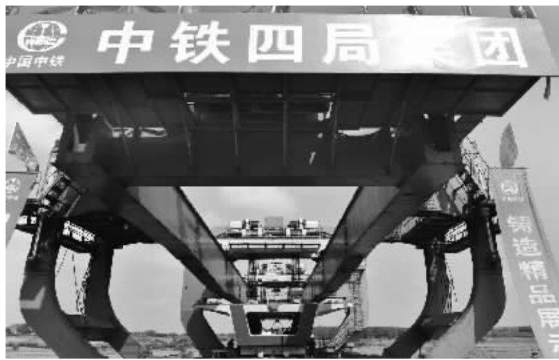
商合杭铁路西山驿特大桥开始架梁 8月8日,中铁四局施工人员在架设西山驿特大桥第一片箱梁。据悉,商合杭铁路起自河南商丘,经安徽亳州、阜阳、淮南、合肥、芜湖、宣城、浙江湖州至杭州,正线长度约794.55公里,设计时速为350公里。
