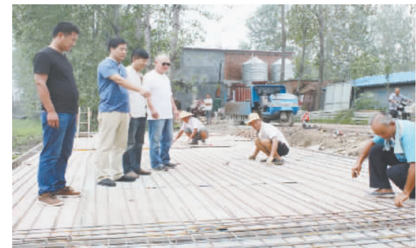
8月17日,筑路工人正在水寨办事处夹河路紧张施工。“以前每到雨雪天气,路就不好走,现在好了,路修到家门口,以后再也不用担心出行困难了。”居民刘祥说。 李光辉 摄
