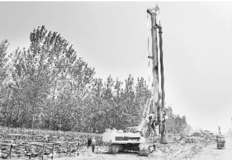
大型机械已经进入场钻孔,准备打桩。
