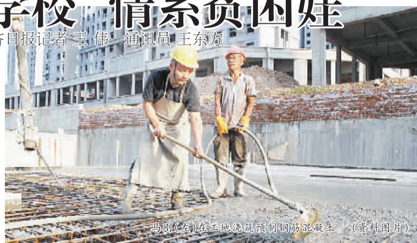
马刚(左)在工地浇筑预制钢筋混凝土。(资料图片)
