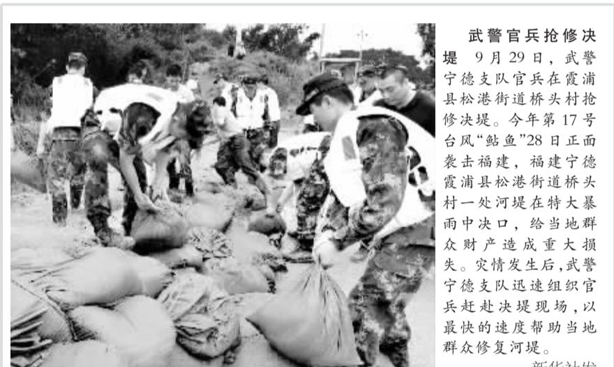
武警官兵抢救决堤 9月29日,武警宁德支队官兵在霞浦县松港街道桥头村抢救决堤。今年第17号台风“鲇鱼”28日正面袭击福建,福建宁德霞浦县松港街道桥头村一处河堤在特大暴雨中决口,给当地群众财产造成重大损失。灾情发生后,武警宁德支队迅速组织官兵赶赴决堤现场,以最快的速度帮助当地群众修复河堤。 新华社发
