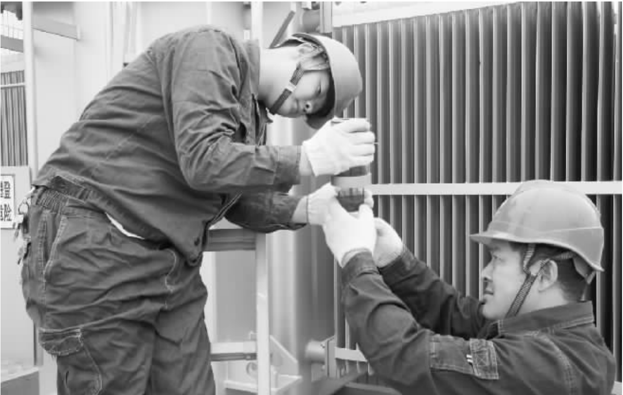
扶沟县供电公司积极组织工作人员精准开展秋检工作，进一步筑牢安全防线。图为 10 月 11 日，该公司变电检修班人员对 35 千伏城关变电站 2 号主变硅胶进行更换。刘军胜 摄
