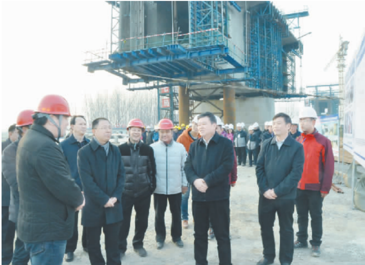
1月23日下午,市委书记、市人大常委会主任徐光到郑合高铁周口段建设现场慰问一线建设者。 记者 王亚辉 摄
