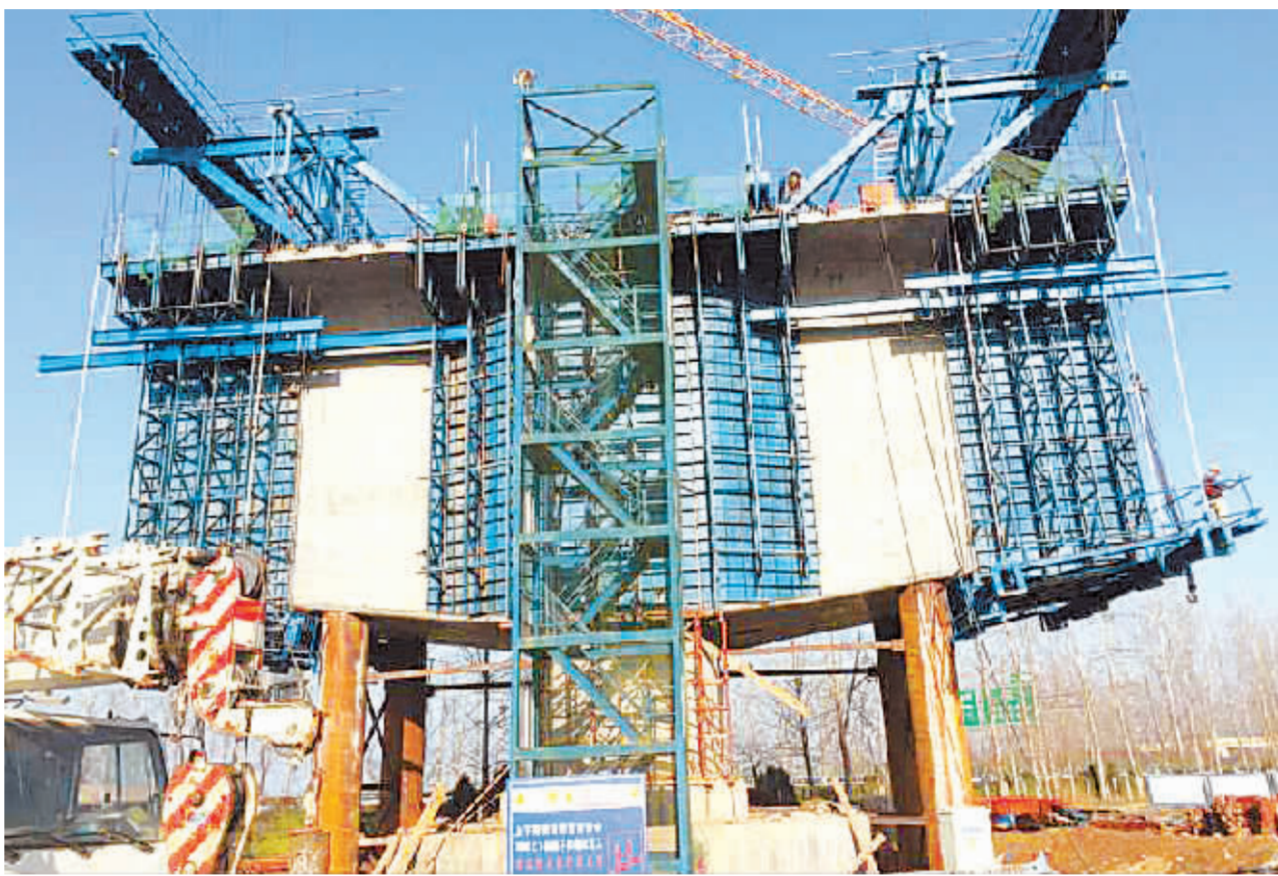
正在建设中的跨商周高速悬臂连续梁工程。记者李一摄
