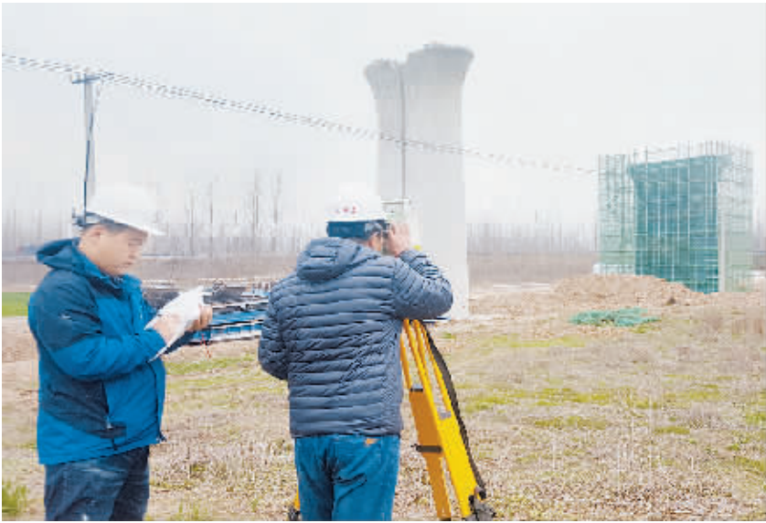
牛月峰(左一)和队员测量跨大广高速工程墩身钢模标准度。
