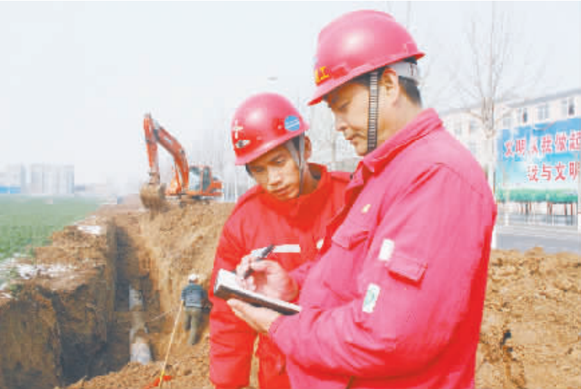
3月4日,周口燃气蒸汽联合循环热电厂的施工人员正在项城市产业集聚区纬五路上铺设准项燃气工程主管线。
