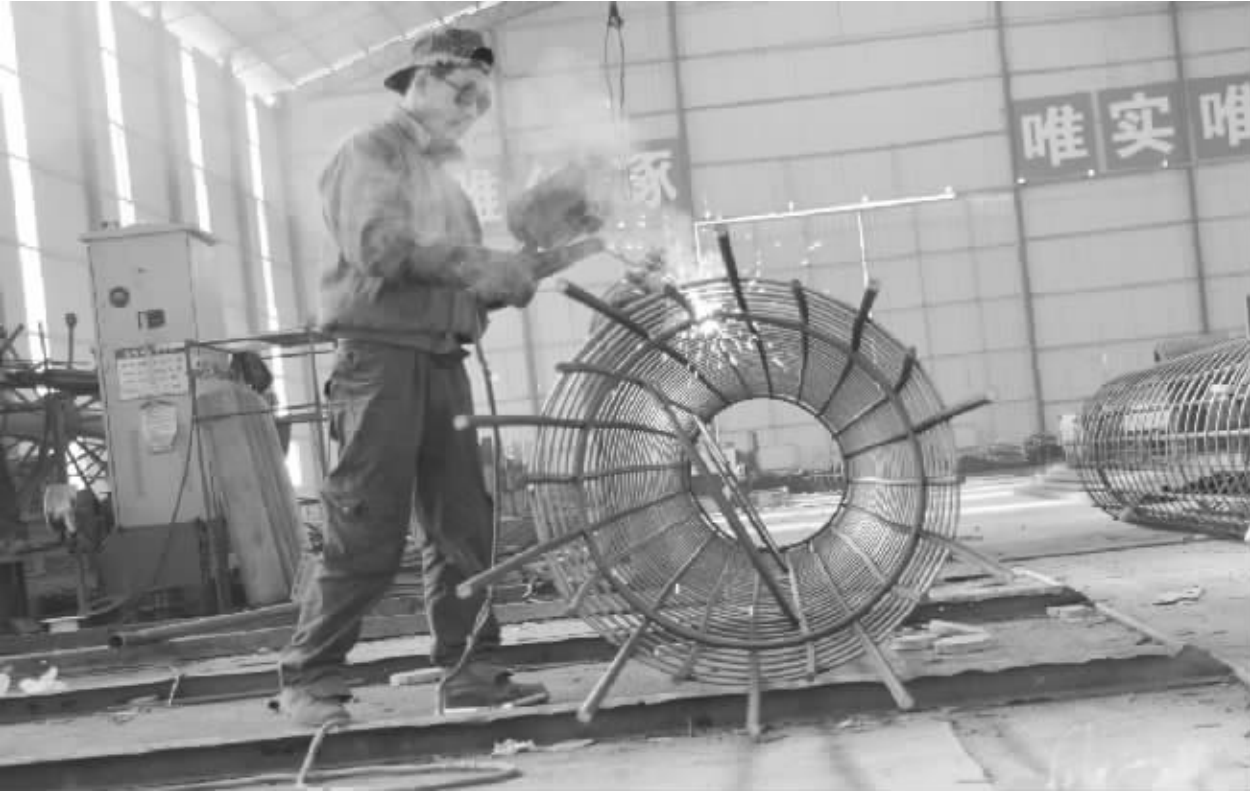
郑合高铁扶沟段建设在有关部门的支持下，施工进度快、质量好，按照施工计划节点积极推进。图为中铁航空港公司施工人员正在进行钢筋笼焊接。 记者 王泉林 摄
