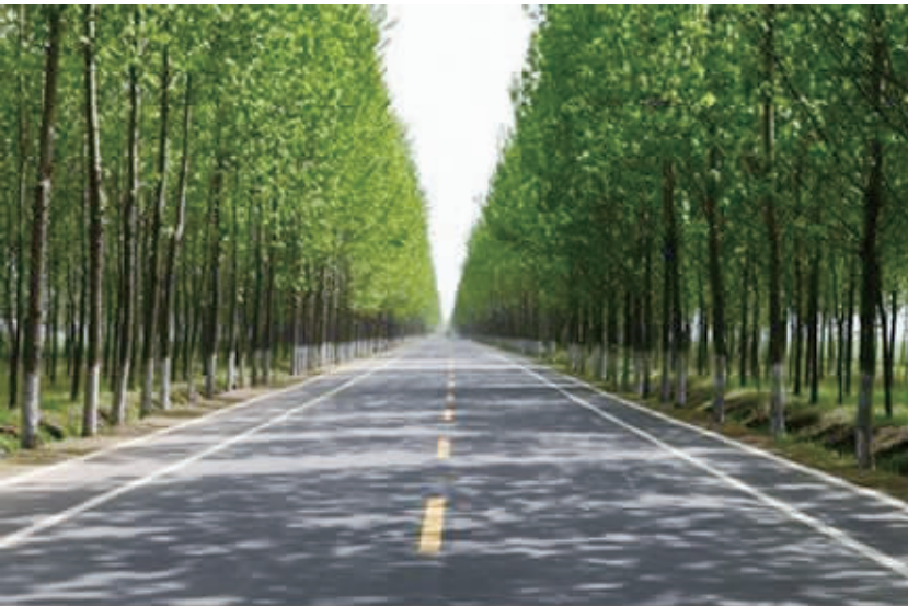
全力服务脱贫攻坚。图为沈丘农村公路项目。
