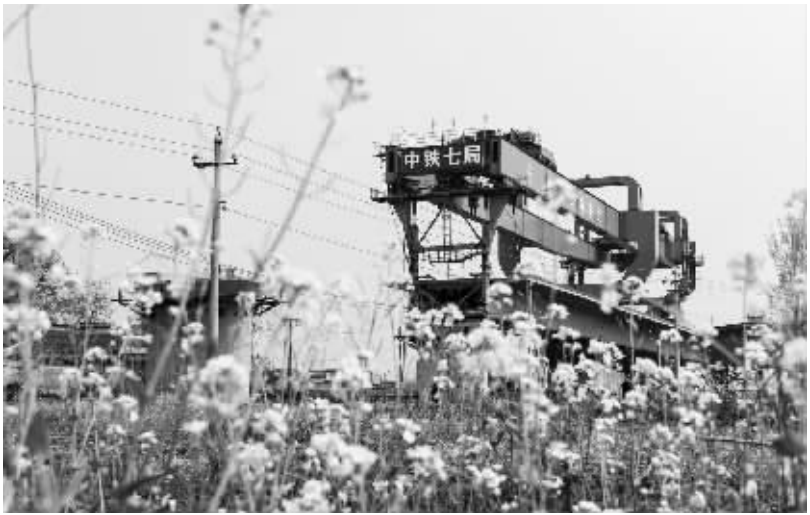
郑万高铁河南段建设稳步推进 4 月 6 日,中铁七局郑州公司的工程人员在郑万铁路河南段 3 标段进行架梁作业。郑万高铁建成后,将成为连接我国铁路西南至东北走向的重要大通道。 新华社发
