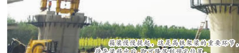
箱梁慢慢提起,这是高铁架梁的重要环节,待导梁移出后,即可降落到预定位置。
