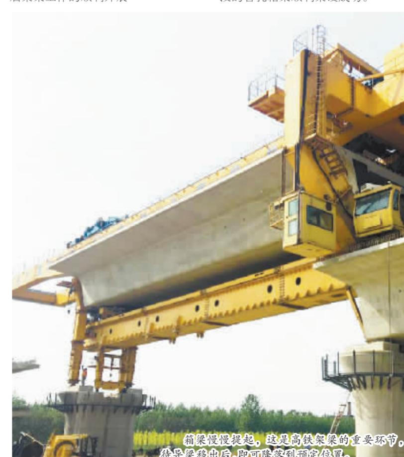
箱梁慢慢提起,这是高铁架梁的重要环节,待导梁移出后,即可降落到预定位置。
