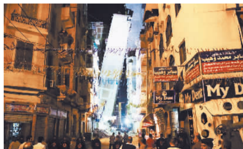
埃及一楼房整体倾斜 倚靠临近楼房 这是6月1日在埃及亚历山大市拍摄的倾斜的楼房。埃及亚历山大市一栋14层的楼房1日发生整体倾斜, 倚靠在临近的一栋楼房上。目前, 亚历山大市政府已疏散楼内及周边住户, 并制定方案对大楼进行安全拆除。 新华社发
