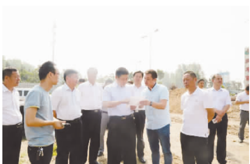
王毅一行在项目建设工地观摩。
