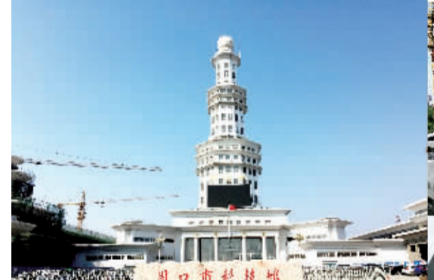
周口市科技馆冷暖项目
