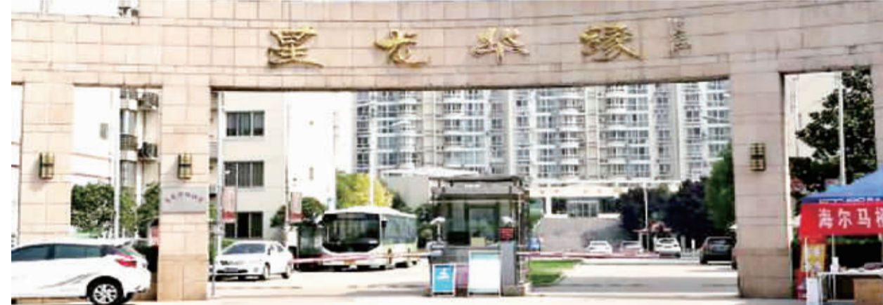
国网周口供电公司家属院供暖改造项目
