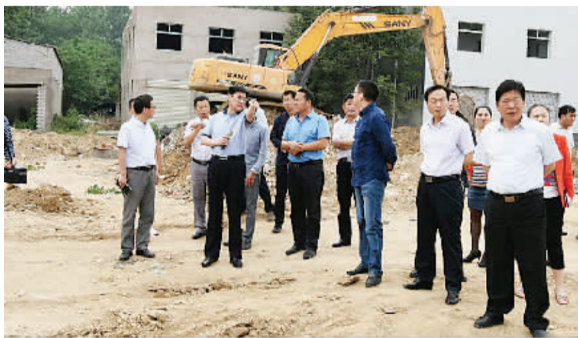
开发区领导田林、李鹏在市重点项目拆迁现场办公
