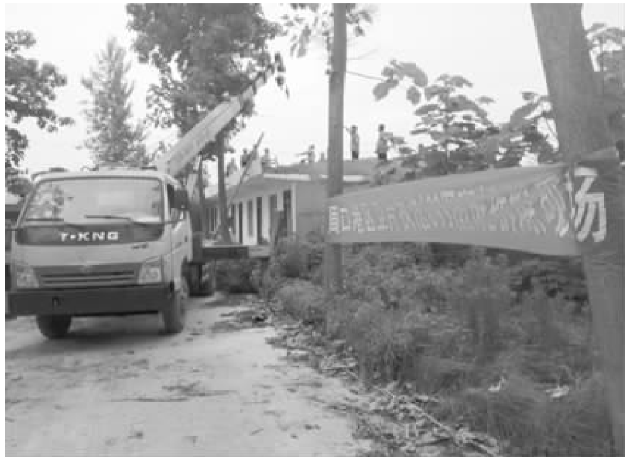
图为拆违现场。
