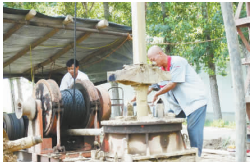
日前,沈丘县水利局组织的机械化施工队正在谢营村打深水井,圆了当地人的饮水安全梦。脱贫攻坚工作开展以来,县委、县政府把解决贫困群众吃水安全问题纳入群众脱贫的硬性指标,取得了明显的成效。 谢辛凌 摄
