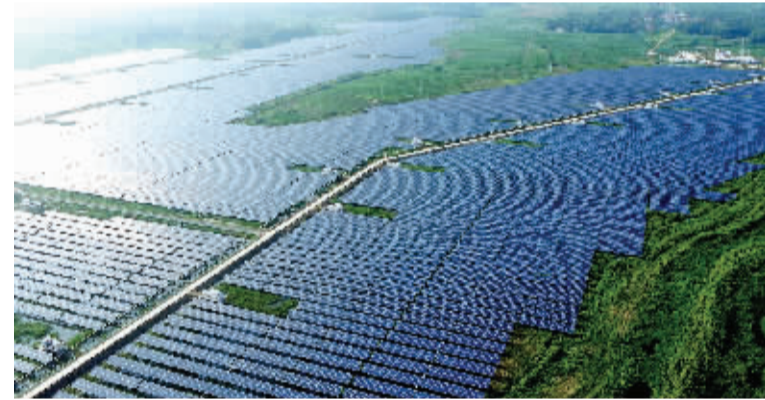
天岗湖光伏发电是华东地区单体规模最大的光伏电站。
