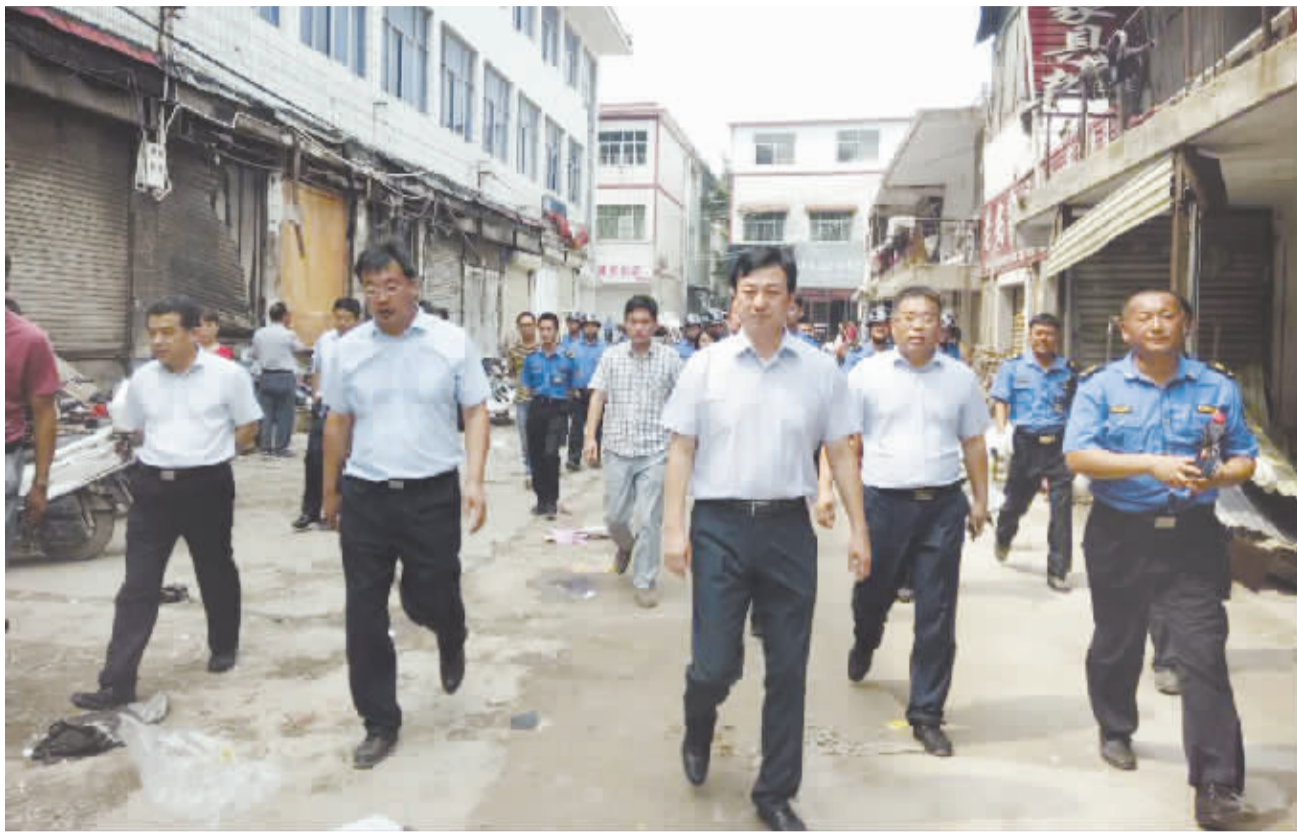
图为县委书记林鸿嘉在一线指挥“两违”建筑拆除工作。张思 摄
