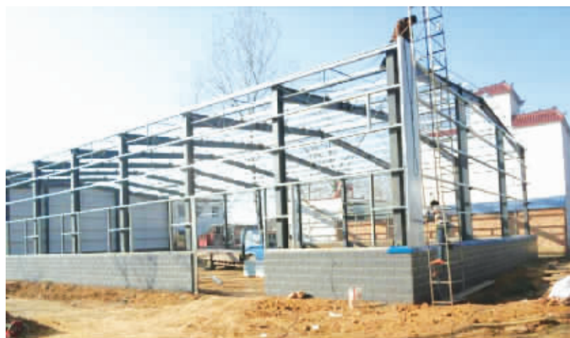
正在建设的村扶贫车间。
