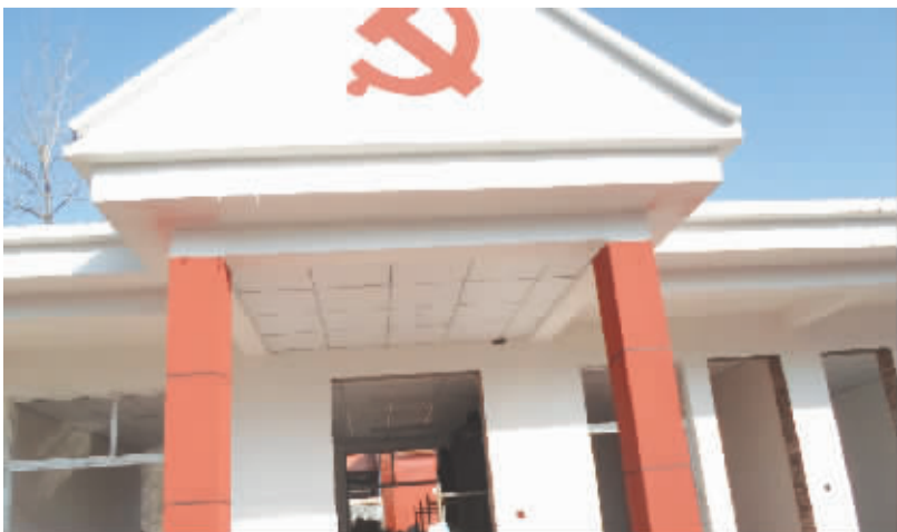
正在建设的村委办公室。
