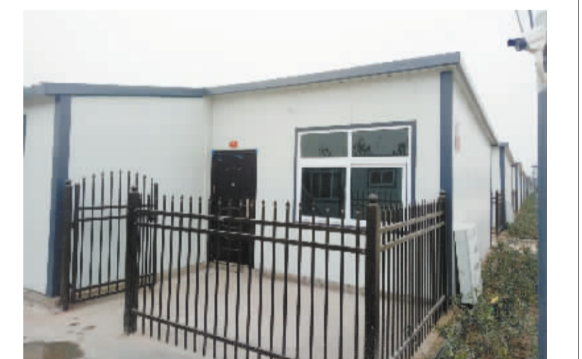
位于兴业东路的沙颍临时过渡安置房经过连天加夜施工，已基本具备入住条件，即将迎来首批住户。王东东 摄
