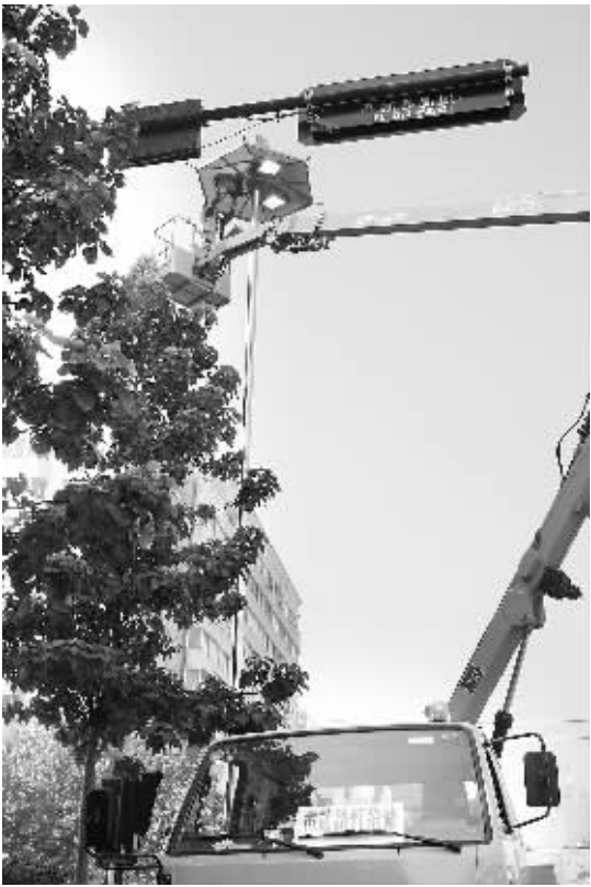
昨日,在市区七一中路上,市政工人们在检修路灯。
