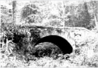
江西宜丰逢渠桥
