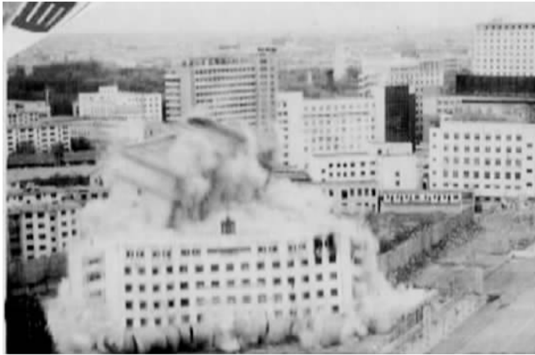
2005年5月17日,刚建成4年的呼市公安局11层指挥大楼被炸掉,目的是给“西北第一高楼”腾地方。新华社发
