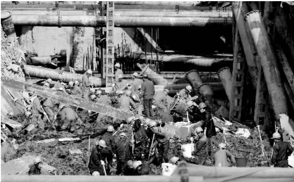
11月18日,工程人员在清理地铁隧道中积压的淤泥。新华社发
