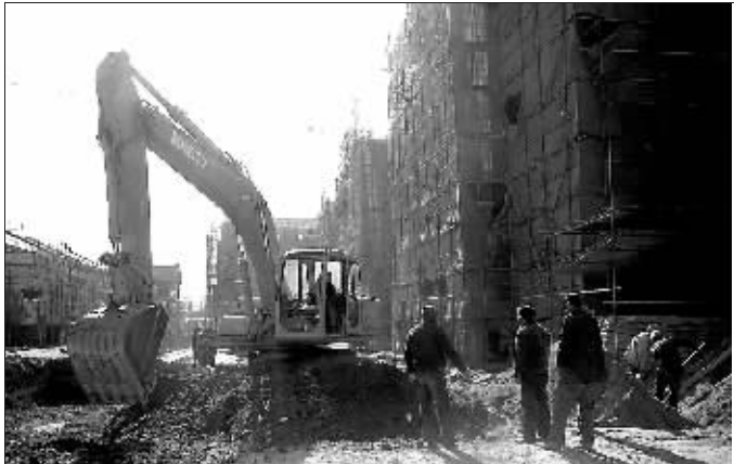
关帝上城施工现场如火如荼。
