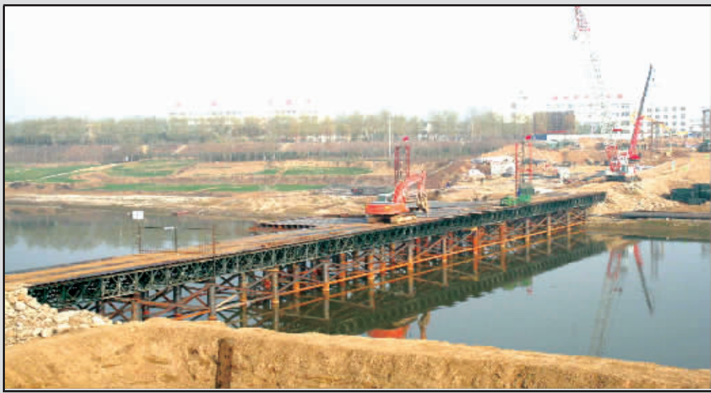
建设中的大庆路大桥
