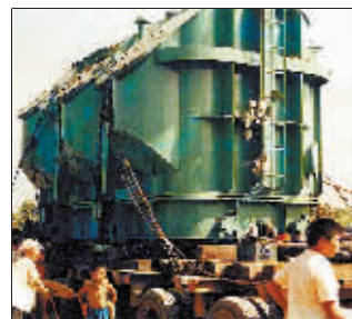
1987年5月,周口第一台220千伏主变进站。
