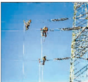
周口第一条220千伏线路——漯淮线施工现场。
