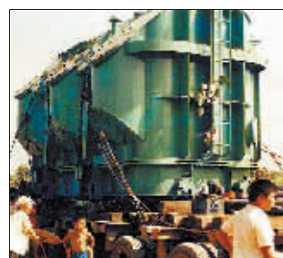
1987年5月,周口第一台220千伏主变进站。
