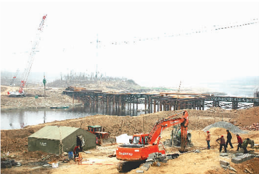
正在建设的市区大庆路大桥
