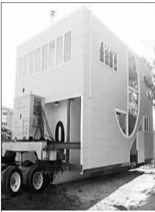
图为大型机械正在搬迁房屋。
