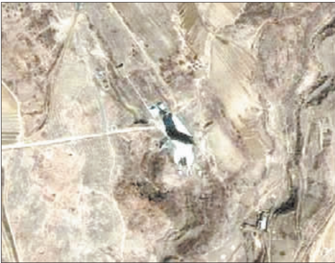
卫星照片显示朝鲜已将火箭安装到发射台上，图中显示火箭竖立后地面已有影子。
