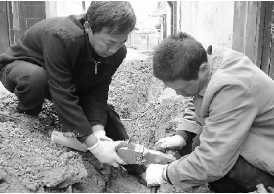
周口银龙水务有限公司安装维修人员自春节以来日以继夜抓紧改造抢修,目前周口市计划改造的 10 个低压供水区已改造完毕 6 个。图为“银龙”工作人员在建西一巷施工。记者 刘彦章 摄
