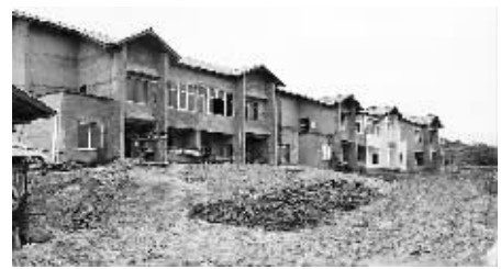
我市援建的大堰乡开化村居民点项目。
