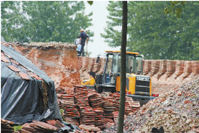
非法砖窑厂施工现场
