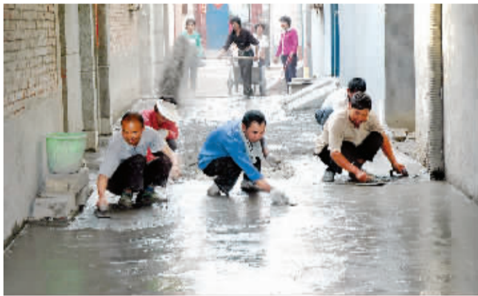
施工人员正在紧张有序地整修路面
