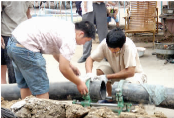
施工人员正在改造供水管网
