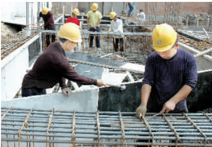
施工人员正在紧张工作
