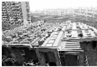
▲ 上海在建13层楼房整体倒覆
