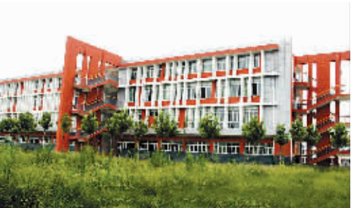
教学楼西立面
