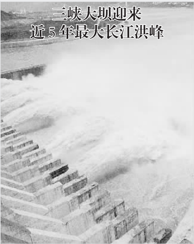
8 月 6 日拍摄的正在开闸泄洪的三峡大坝。当日,三峡大坝迎来 2004 年以来最大流量的长江洪峰,从 8 时至 14 时,三峡水库入库流量维持在峰值 55000 立方米/秒左右。这次洪水洪量大、涨势陡、持续时间长。大坝已开启 7 个深孔和 2 个排漂孔。 新华社发
